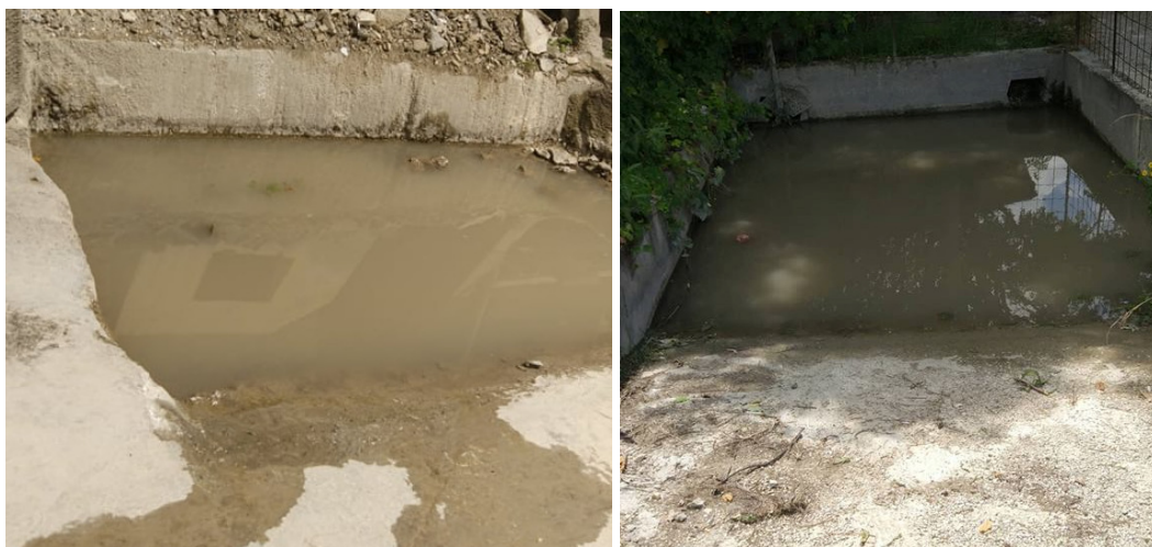
Слика 8. Примарен и Секундарен таложник за отпадни води од перење на бетоњера Елба 40
