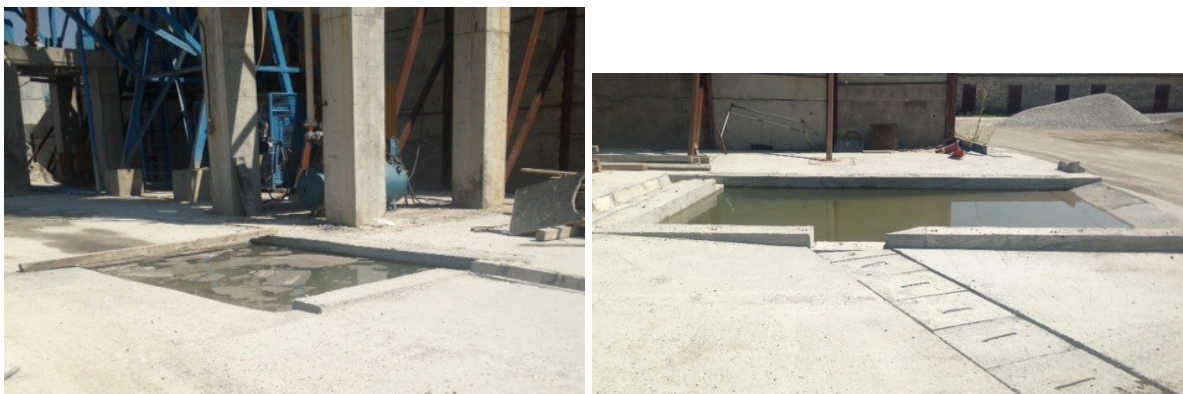
Слика 7. Примарен и Секундарен таложник за отпадни води од перење на бетоњера Елба 85
